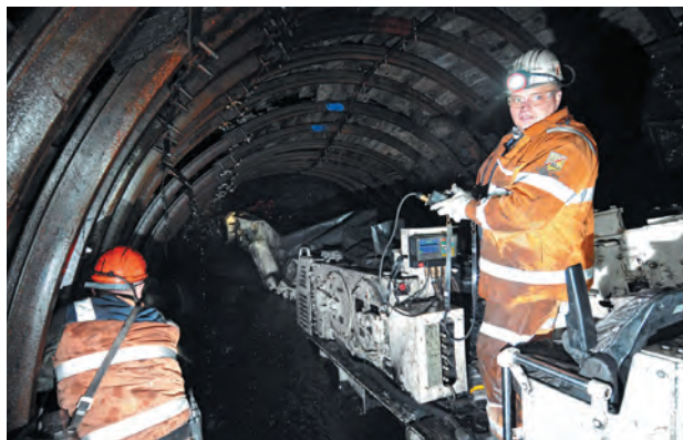
Проходческий комбайн КП21 на шахте «Воргашорская»
