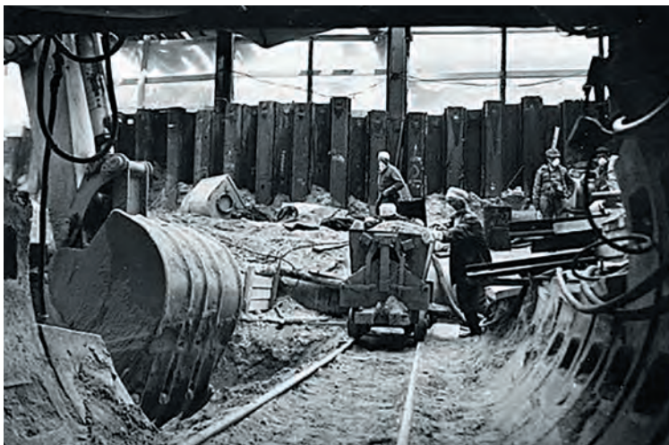
Проходка тоннеля под реактором 4-го энергоблока
