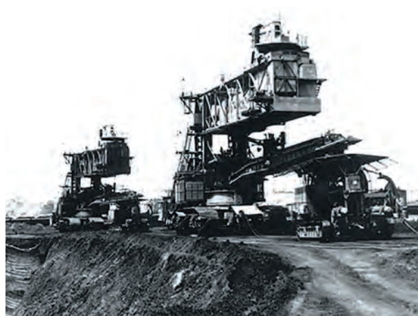
Перегон с монтажной площадки двух экскаваторов на разрезе «Богатырь» на ввод 2-й очереди строительства мощностью 5 млн т, 1971 г.
