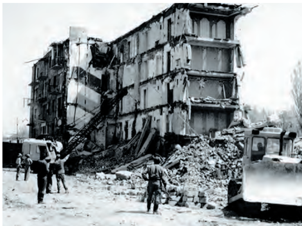
Жилой дом в г. Спитак после землетрясения
