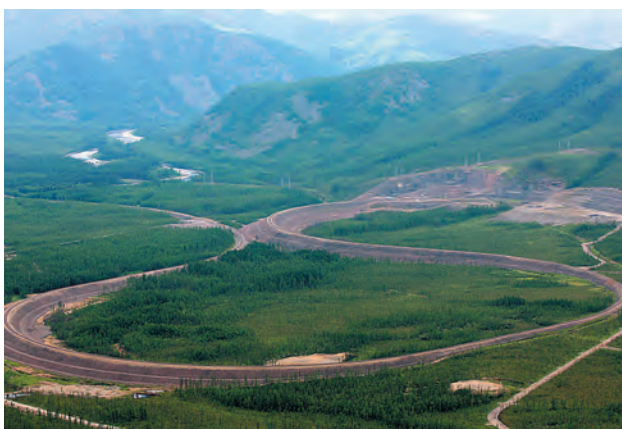
Железнодорожная трасса Улак-Эльга, 232 км пути
