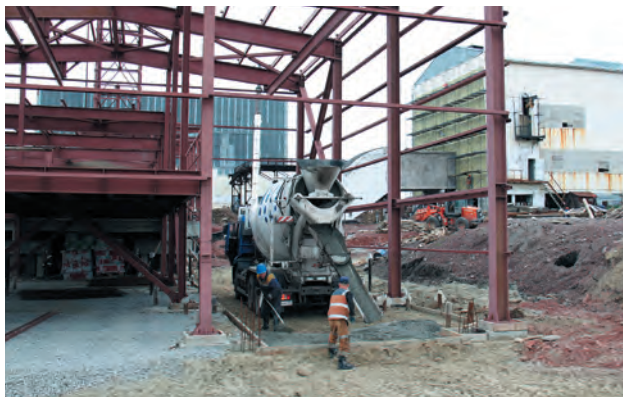
Строительство вентиляционного ствола № 4 шахты «Заполяная»
