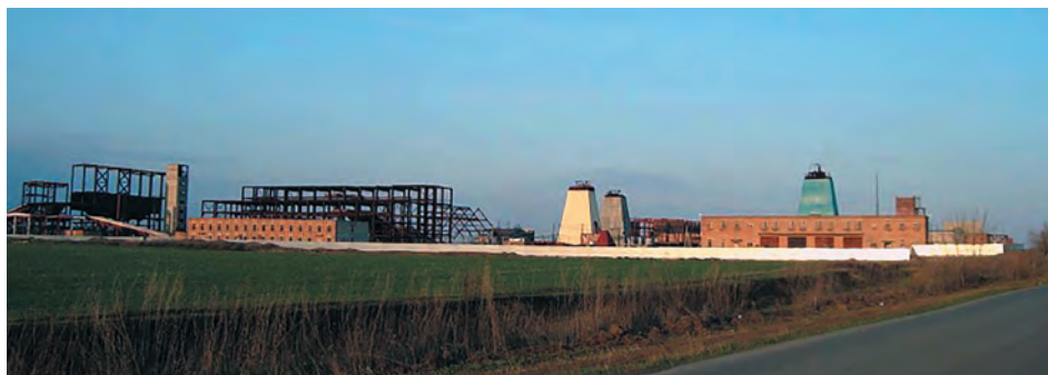
Промплощадка строящейся шахты «Обуховская № 1»
