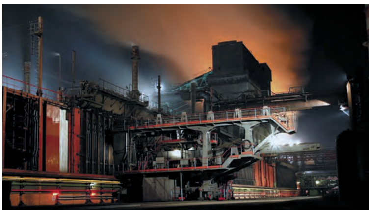
Батареи Кемеровского коксохимического завода
