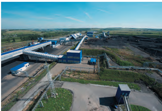
Флагман углеобогащения «Стройсервиса» – обогатительная фабрика «Матюшинская» с мощностью переработки 4,8 млн т угля в год
