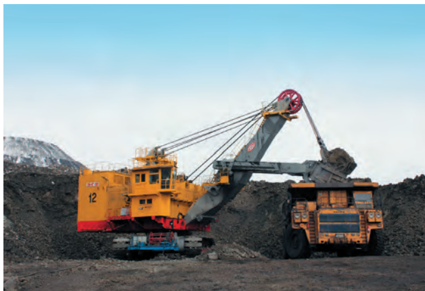
Вскрышные работы на разрезе «Нерюнгринский»
